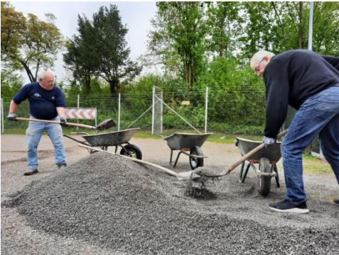
Mehr als 4 Tonnen Split mussten aufs Gelände
