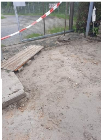
Rechts: damit ein gefahrloser Zugang zum Vereinsheim weiterhin möglich ist, wurde ein Provisorium erstellt.
