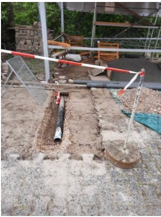
Links wurden Leerrohre eingeführt.
