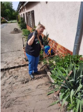
Links: Katrin bei der Vorbereitung zum Betondurchbruch.
