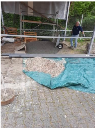
Mineralbeton und Splitt wurden gehortet. Peter hatte natürlich alles im Griff
