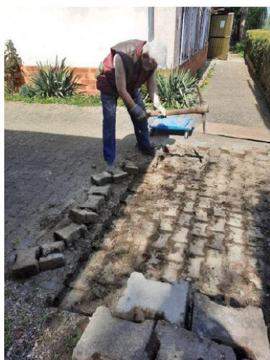
Fleißige Hände beim Knochensteine entfernen und Leerrohre verlegen.
