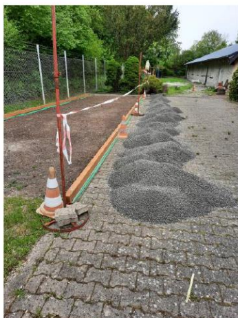
Boule Anlage kurz vor der Fertigstellung
